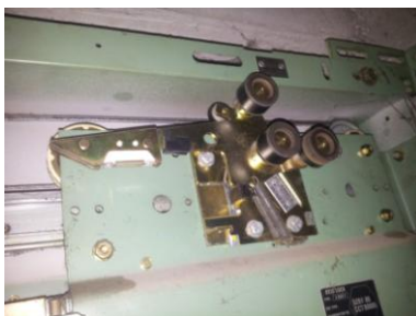
Serrure de porte palière du niveau principal
